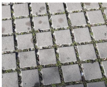
Pavés drainants à joints enherbés (à gauche), parking alvéolaire engazonné au centre (Ecovégétal), enrobé drainant à droite (Applied technologies)
