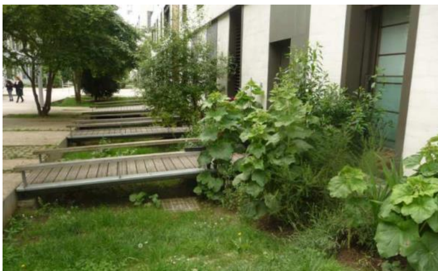
Noûe infiltrante au droit d'un bâtiment (Cerema)
