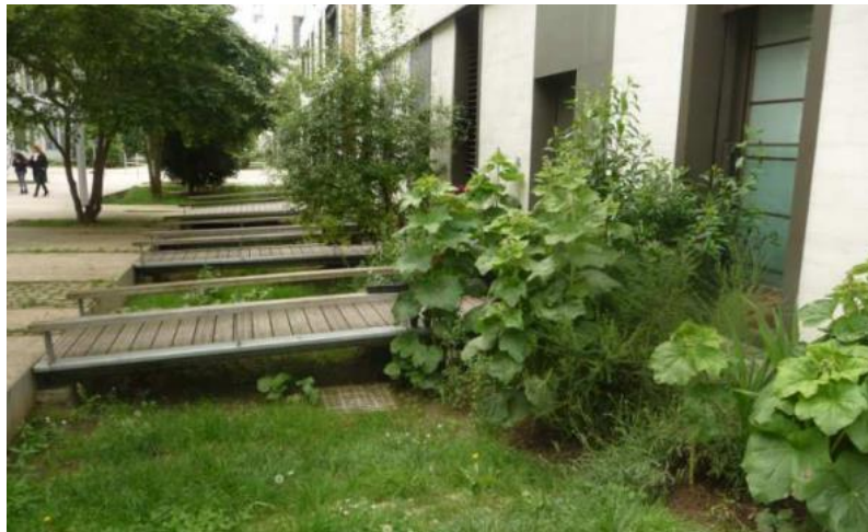
Versickerungsrinne an einem Gebäude (Cerema)
