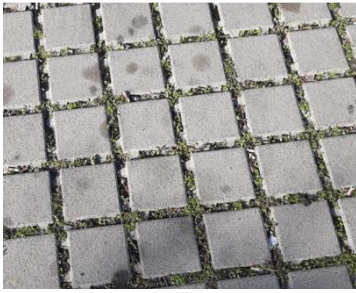
Drainagepflastersteine mit begrünten Fugen (links), begrünter Parkplatz mit Hohlraumpflaster in der Mitte (Ecovégétal), Drainageasphalt rechts (Applied Technologies)
