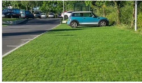
Drainagepflastersteine mit begrünten Fugen (links), begrünter Parkplatz mit Hohlraumpflaster in der Mitte (Ecovégétal), Drainageasphalt rechts (Applied Technologies)
